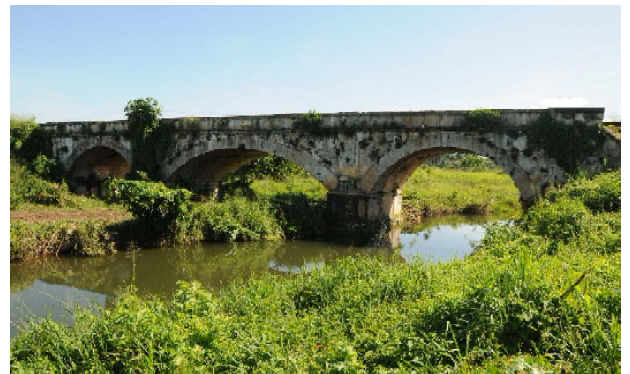
Puente del ferrocarril de Matanzas sobre el río San Andrés, a la entrada de Unión, realizado por Julio Sagebien, 1848.
