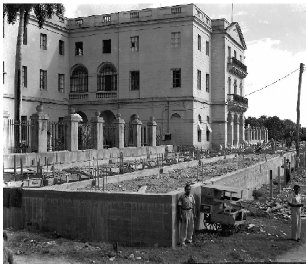
Hospital Santa Isabel antes de la remodelación.
