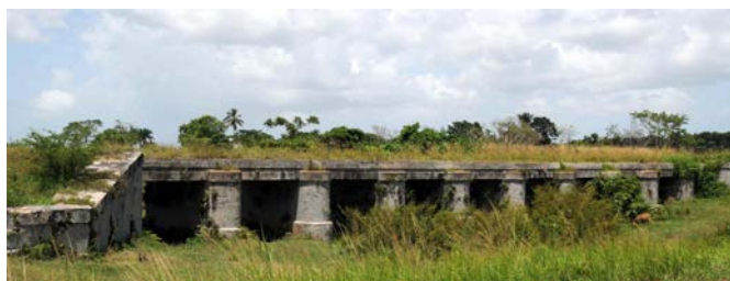
Puentes de ferrocarriles entre Banagüises y San José de los Ramos.
