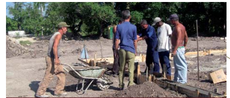
Une autre en chantier (Caonao) ...
