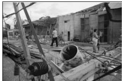
Les effondrements partiels ont été nombreux.
