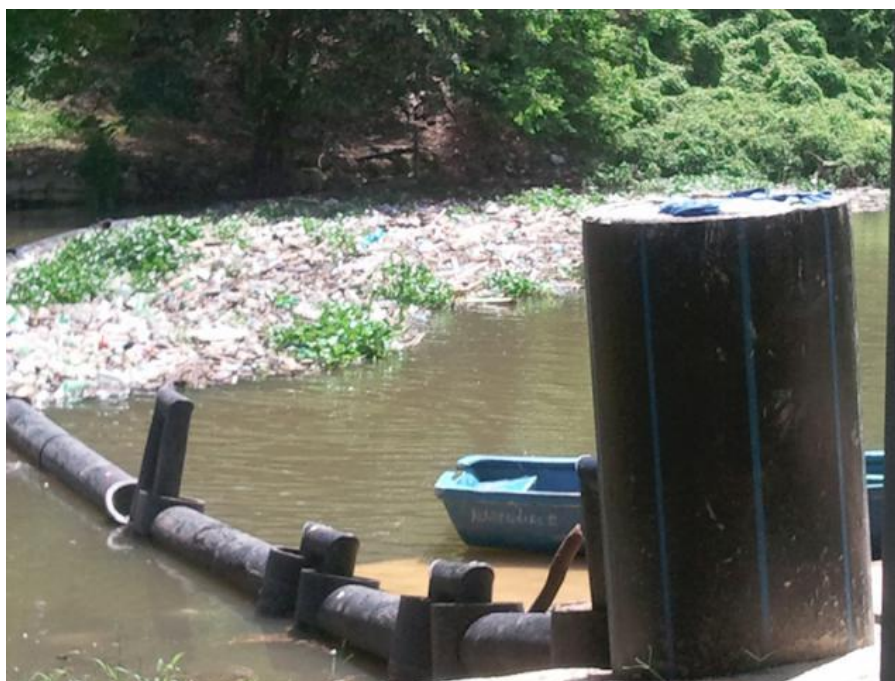
Barrage flottant fait avec des tuyaux en PEHD fabriqués à Ciego de Ávila.
