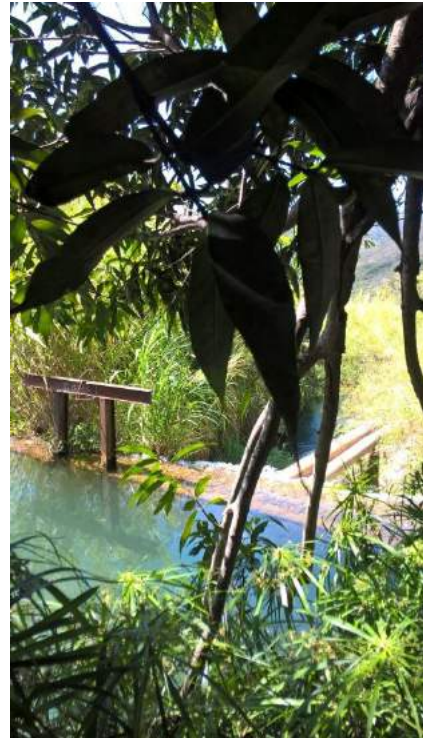
Le barrage, la déverse en pleine activité !
