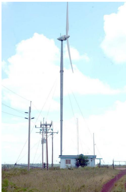
Des travaux sont actuellement en cours pour la construction de deux parcs éoliens. Photo: Ismael Batista
