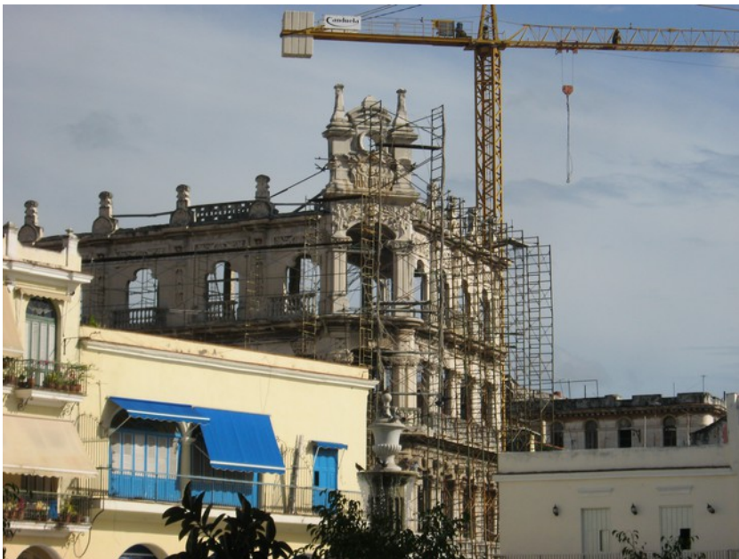
Travaux de restauration dans la vieille ville
