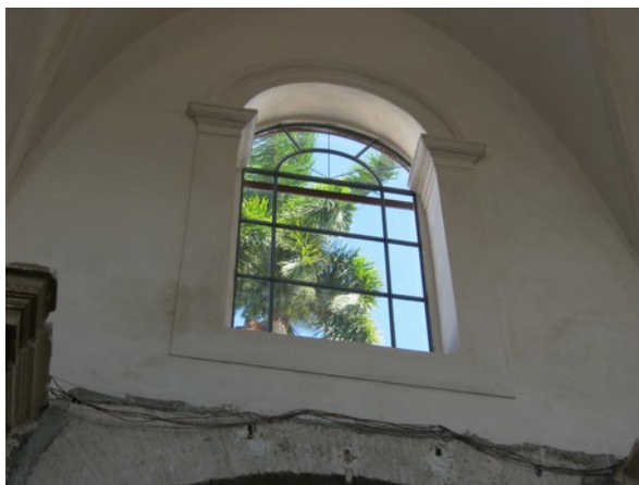
Intérieur de l'église de la ville dont les vitraux doivent être restaurés par les élèves de l'école de restauration des bâtiments anciens.
