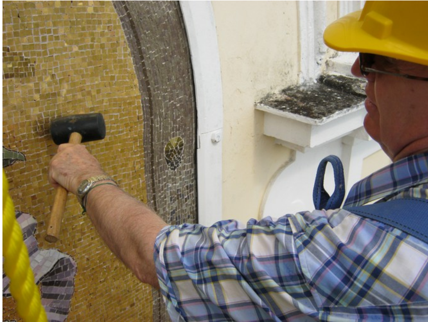
Verdiano Marzi sondant à l'aide d'un maillet afin de constater l'état d'adhésion des mosaïques au support.
