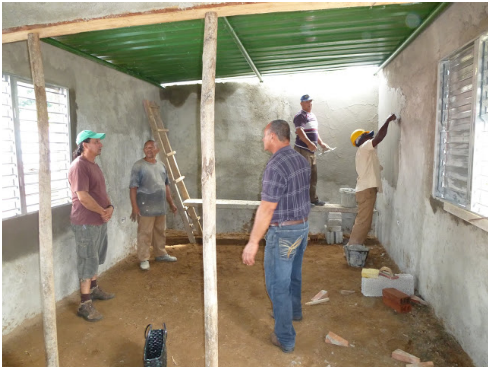
Finition du gros-oeuvre
