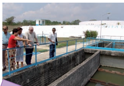
Visite d'une station d'épuration
