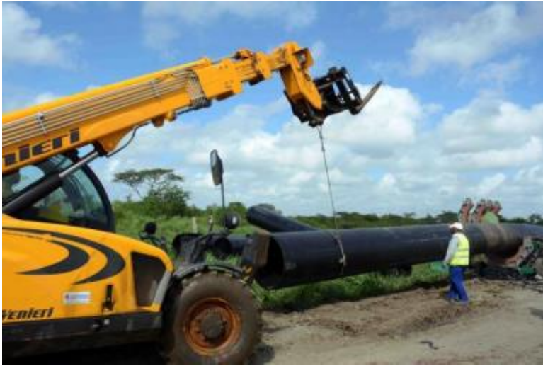
Pose d'une nouvelle conduite d'eau dans la région de Camagüey
